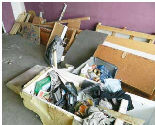
Nemáte zájem o „luxusní“ bydlení v Litvínově-Janově? Takových bytů je tady více než dost. Pokud velice rychle stát nezačne problémy řešit, hrozí devastace dalších domů.
