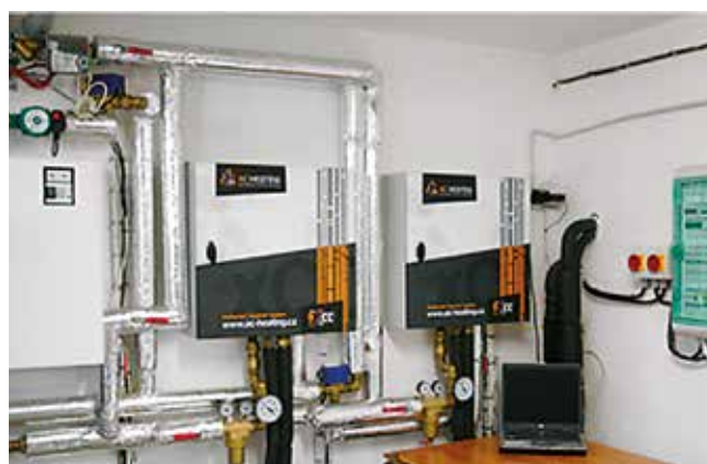
Poznaňská 12, Brno Žabovřesky – vnější jednotky na střeše a vnitřní jednotky, elektrokotel a rozvaděč elektro
