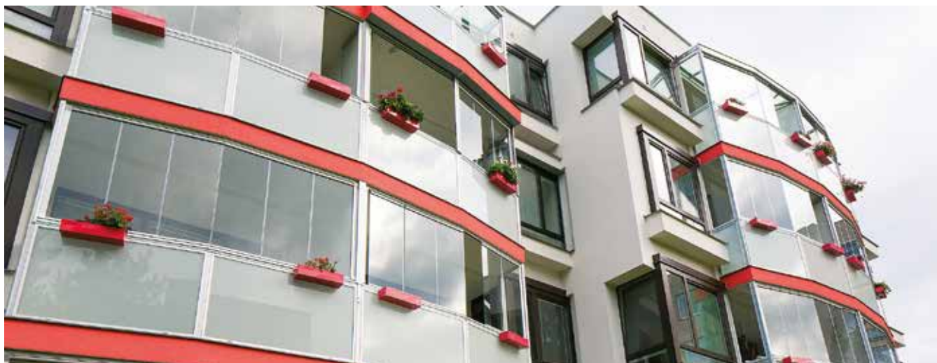
Ocelové konstrukce vynesly lodžie a zvětšily je do netradičního mírně lomeného tvaru. Hradec Králové
