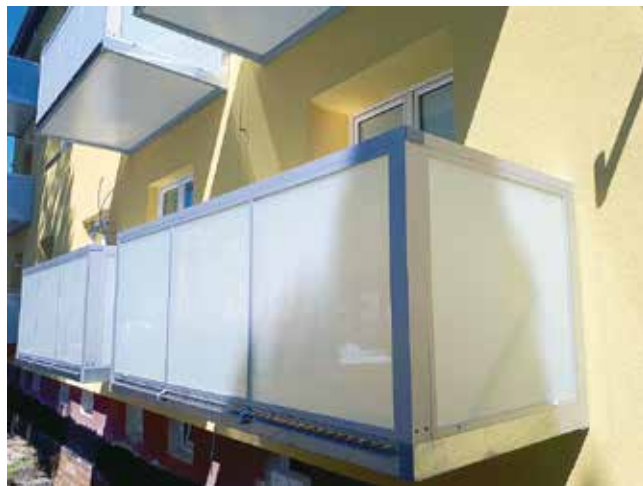
Nová konstrukce s hliníkovým opláštěním a kotvením bez mezery
