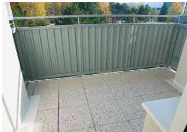
Rozšíření betonové lodžie
