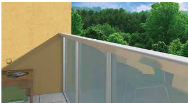
Nové madlo hliníkového zábradlí
