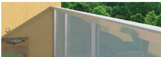
Nové madlo hliníkového zábradlí
