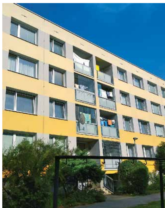
Panelový dům v Praze – Letňanech, Letovské ulici, 36 bytů, spuštěno 2019
