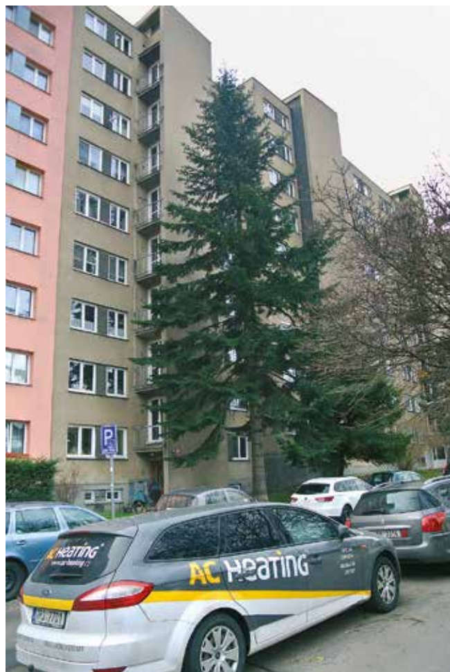
Panelový dům v Praze, Bělčické ulici, 18 bytů, spuštěno 2019
