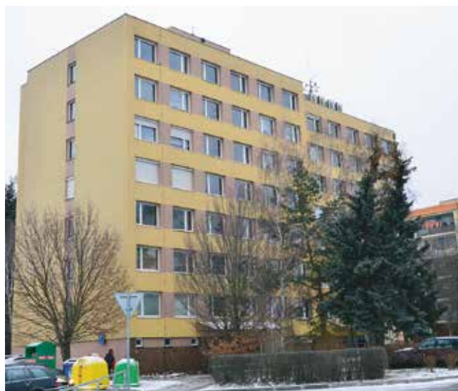
Panelový dům v Králově Dvoře, ulici Pod Hájem, 42 bytů, spuštěno 2019
