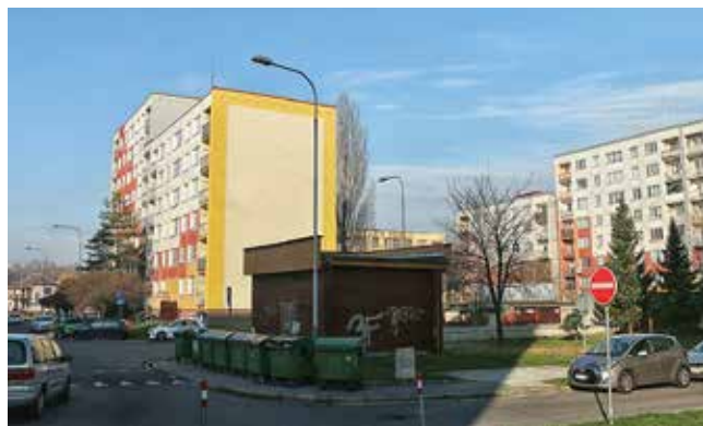
Současný pohled na tytéž domy již po revitalizaci
