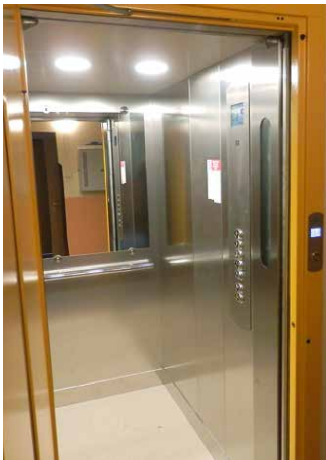
Havlíčkova č.p. 1191–1193 Val. Meziříčí, nové výtahy – rok 2017
