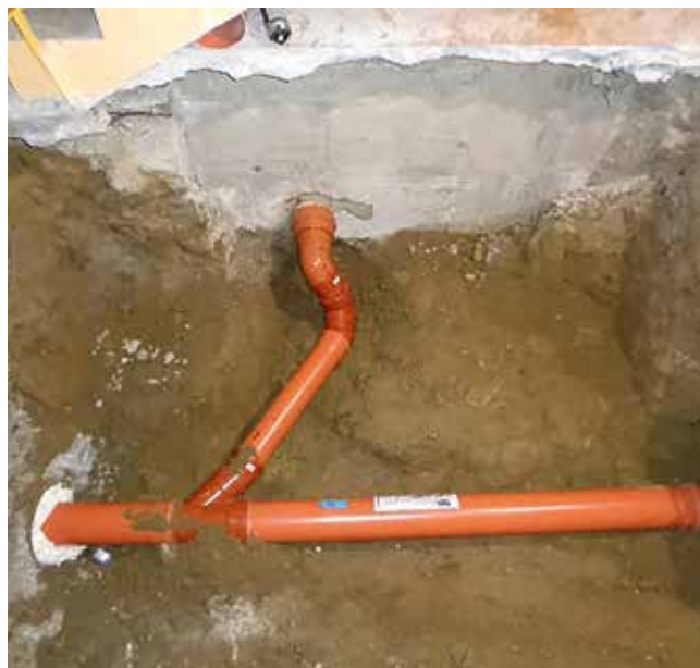
Přeložka kanalizace v místě prohlubně nového výtahu
