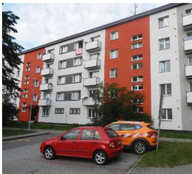
SVJ Jičínská č.p. 718-719 Val. Meziříčí, revitalizovaný panelový dům – rok 2018
