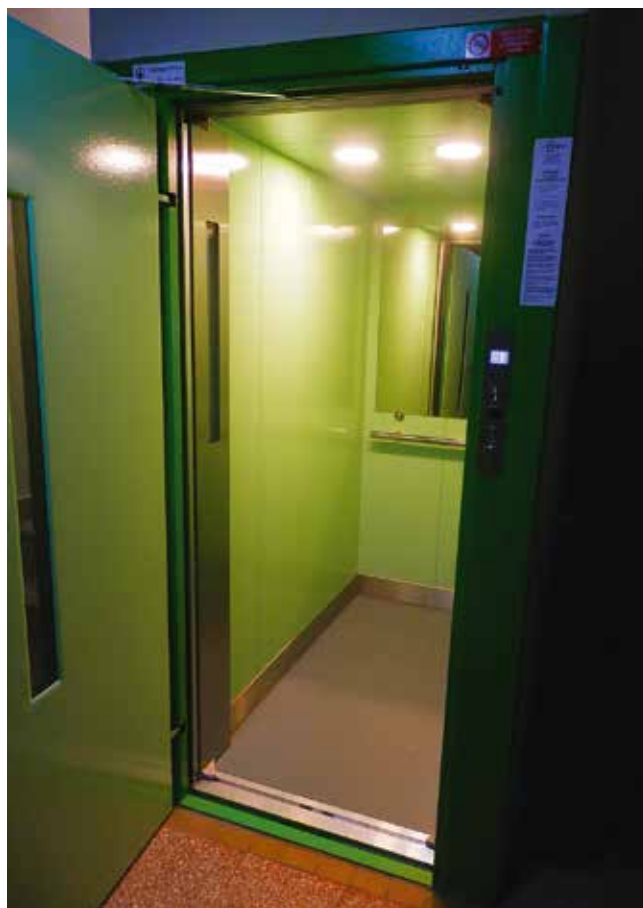
U Vodojemu č.p. 1167 Val. Meziříčí, nový výtah – rok 2019
