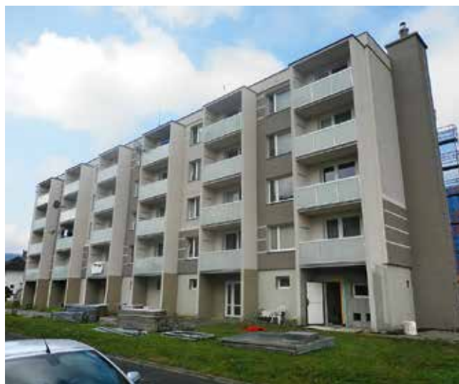
SVJ Poličná č.p. 424-426, revitalizovaný panelový dům – rok 2019
