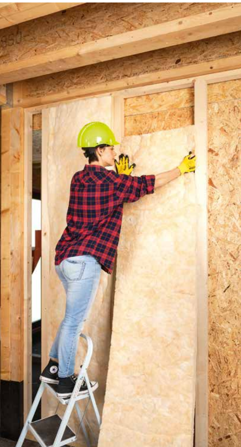
Úspěšné řešení konstrukcí příček výrazně přispívá ke komfortu bydlení
