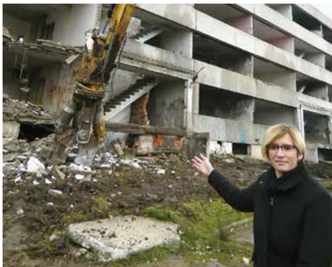
Na fotografii z listopadu 2016 přímo z místa ministryně pro místní rozvoj Karla Šlechtová ukazuje na výsledek své práce na části demolovaného bloku 1 v Chanově. Předtím se ujala ovládacích pák demoličního stroje, zvládla je a výsledek její aktivity byl na světě.
