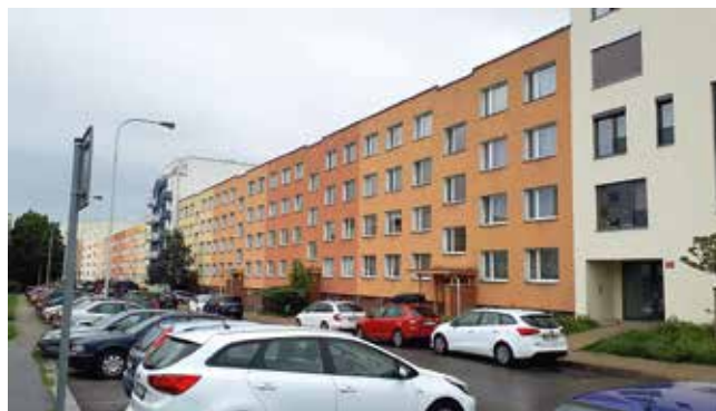
obr.2 Letovská 550-553, Praha, 72 bytových jednotek
