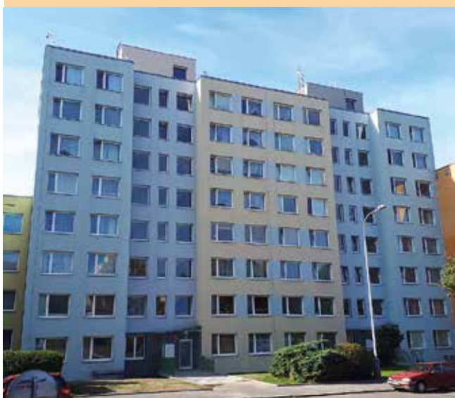
obr.1 Křivenická 416-417, Praha – 50 bytových jednotek
