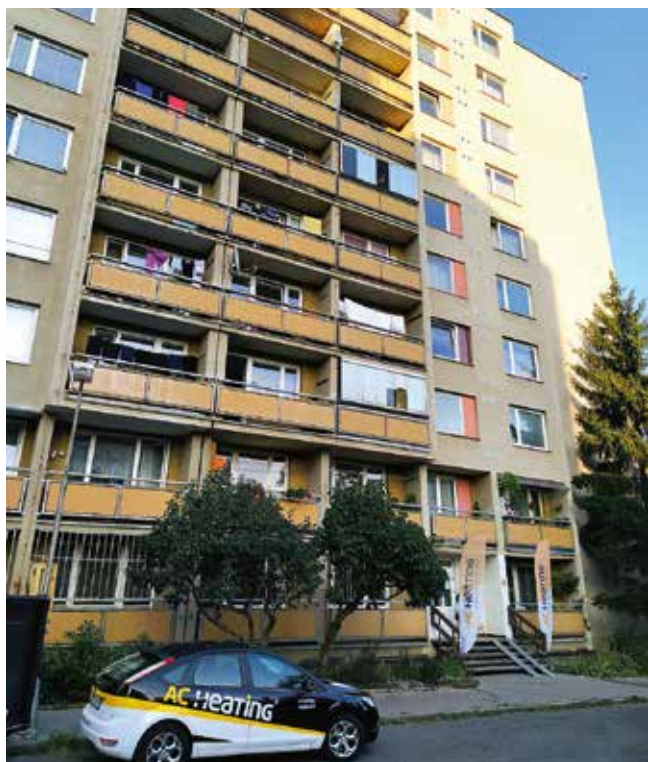
Bytový dům Čechovská 69, Příbram, 41 bytových jednotek
