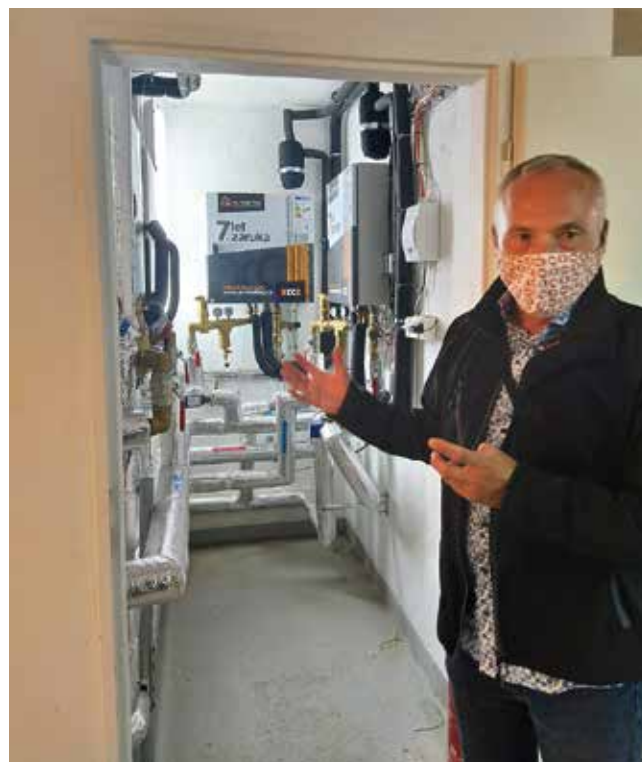
Bytový dům Čechovská 69, Příbram, 41 bytových jednotek
